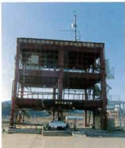
屋上まで波に沈んだ南三陸町役場防災対策庁舎
